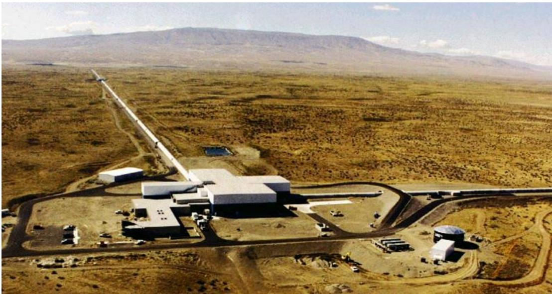
**Bild 1:** Das nördliche Interferometer der LIGO-Kollaboration in Hanford (Washington). Die L-förmigen Interferometerarme sind jeweils 4 Kilometer lang. Eine baugleiche Anlage steht in Livingston (Louisiana). Die Gravitationswelle wurde fast zeitgleich in beiden Interferometern registriert. © LIGO (Laser Interferometer Gravitational-Wave Observatory) Kollaboration.
